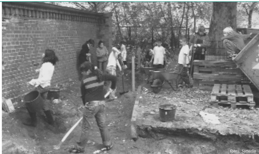
Viele Schüler graben mit für den neuen Vorplatz des Milchhäuschens der Nürtingen-Schule in Kreuzberg.
